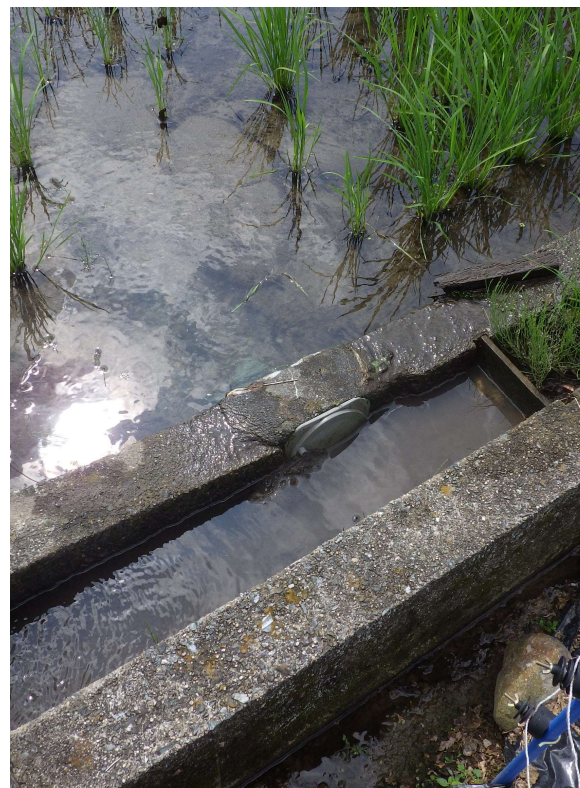
取水口のせき止め
