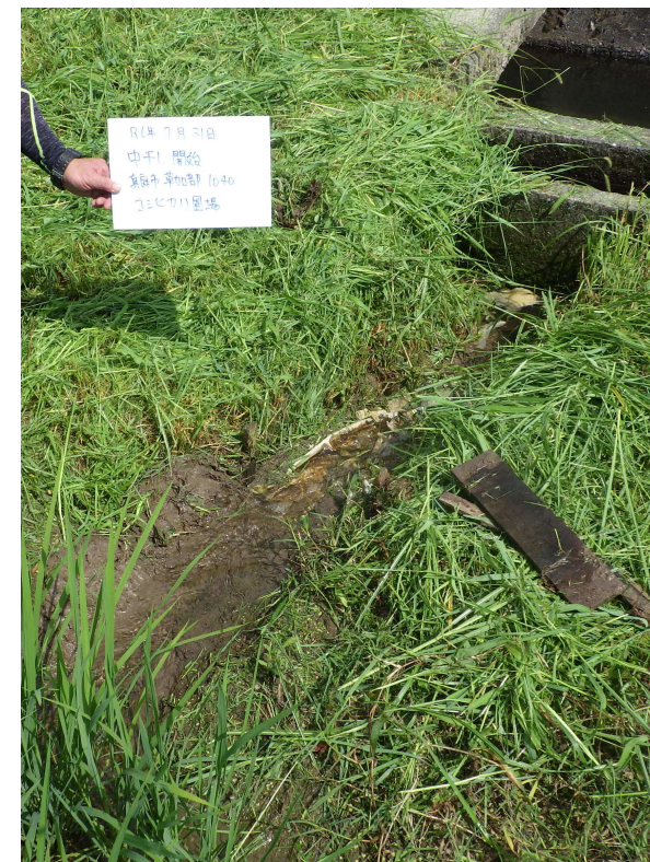
排水口の せき止め板解除
